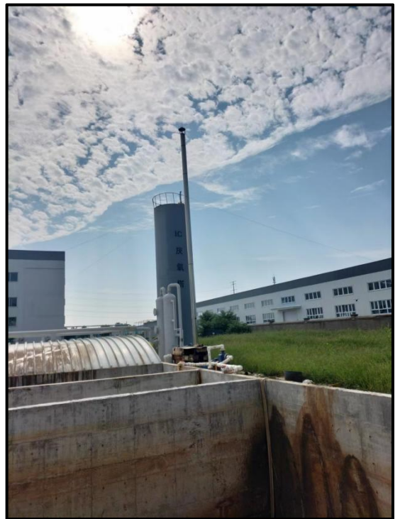
污水处理站废气处理设施
