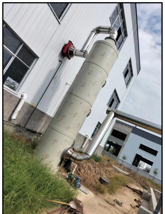
生产废气处理设施喷淋装置
